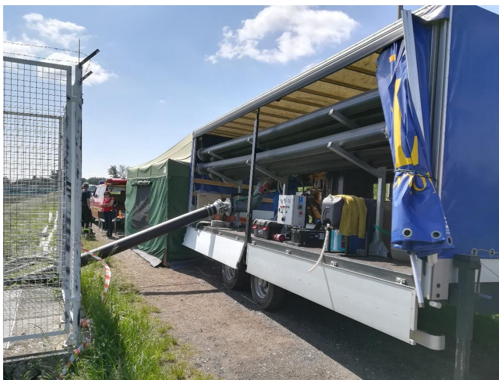
Fot. 4 Pompowanie przy przepuście Moderz-Olszynka
