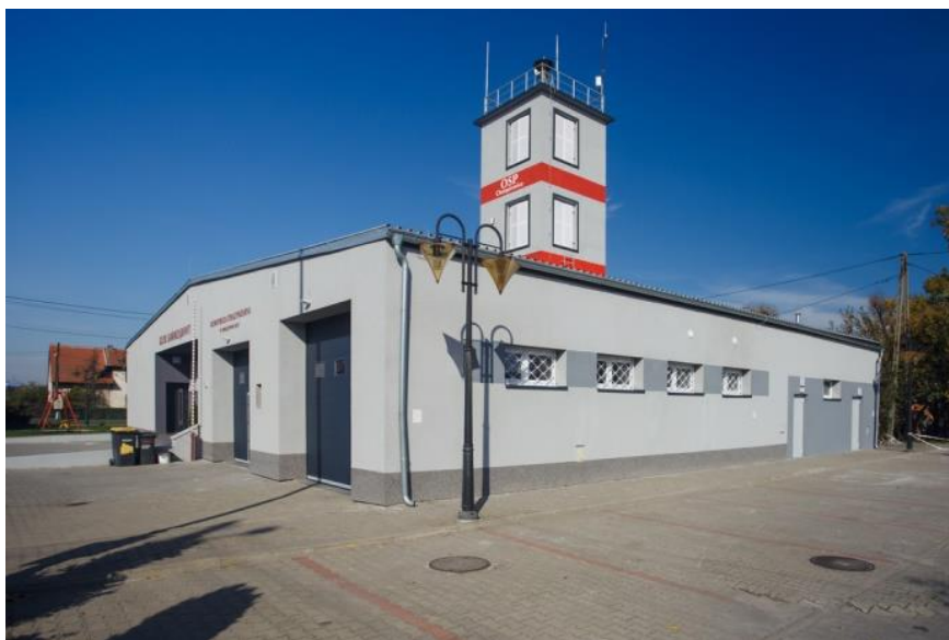
Zdjęcie nr 11 Termomodernizacja budynku klubu samorządowego z remizą OSP w Chrzęstowicach. Źródło: przekazane przez Gminę Chrzęstowice.
