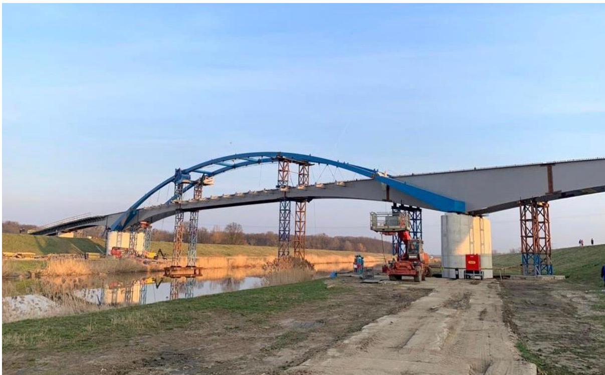
Zdjęcie nr 3 Bezpieczny Transport w Opolu, element projektu (kładka pieszo-rowerowa przez rzekę Odre). . Źródło: przekazane przez Miasto Opole.
