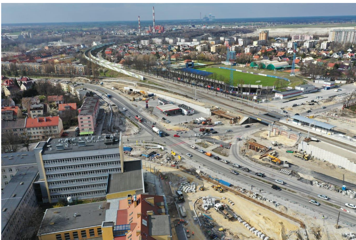
Zdjęcie nr 4 Poprawa funkcjonowania systemu transportu publicznego oraz zastosowanie rozwiązań zwiększających bezpieczeństwo ruchu drogowego w obrębie stacji kolejowej Opole Wschód. . Źródło: przekazane przez Miasto Opole.
