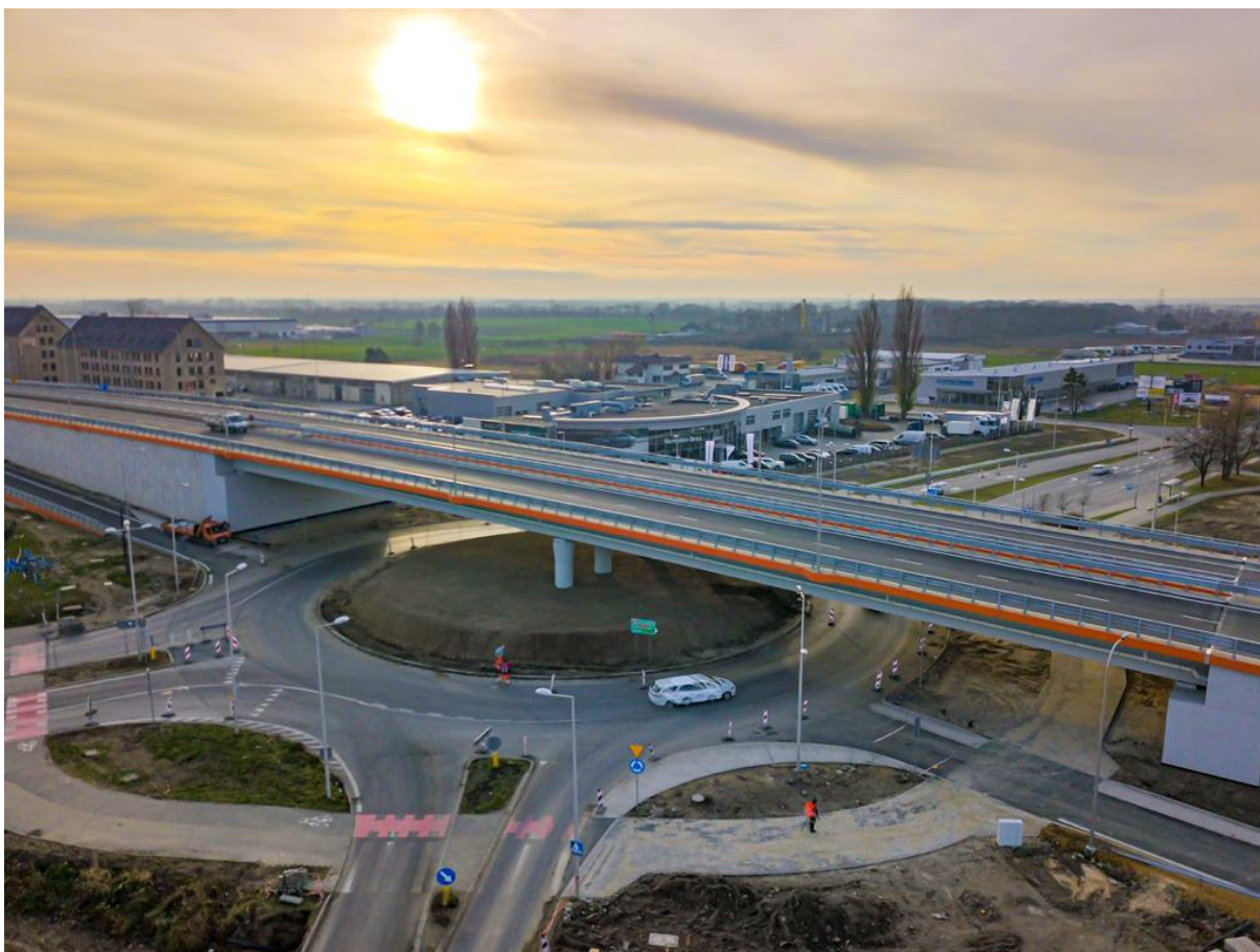
Zdjęcie nr 1 Budowa Obwodnicy Piastowskiej miasta Opola od ul. Niemodlińskiej do Obwodnicy Północnej. Źródło: przekazane przez Miasto Opole.
