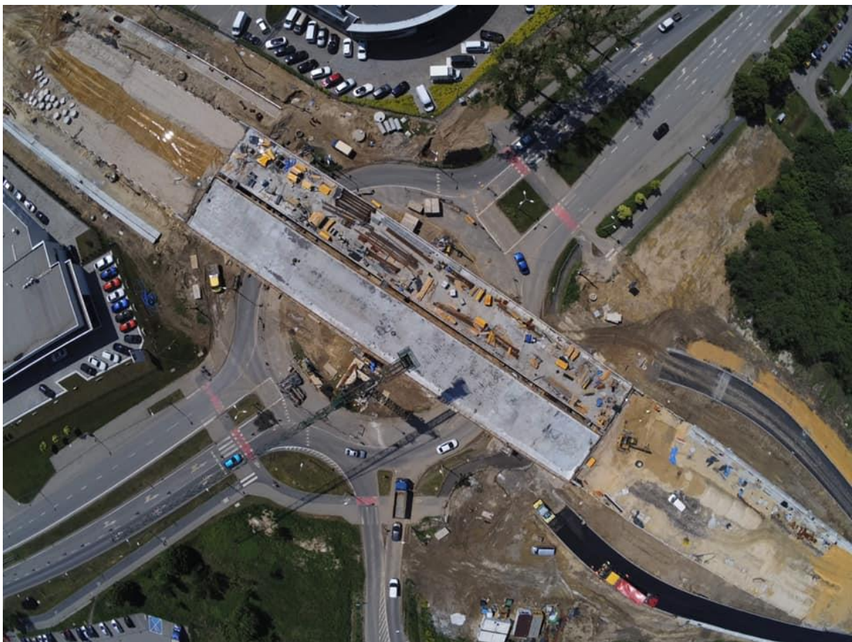
Zdjęcie nr 5 Budowa obwodnicy piastowskiej w Opolu odcinek od obwodnicy północnej do ul. Krapkowskiej Etap II od węzła Niemodlińska do obwodnicy północnej
