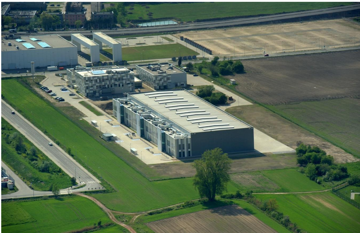
Zdjęcie nr 10 Budowa Opolskiego Parku Naukowo- Technologicznego projekt III i projekt IV
