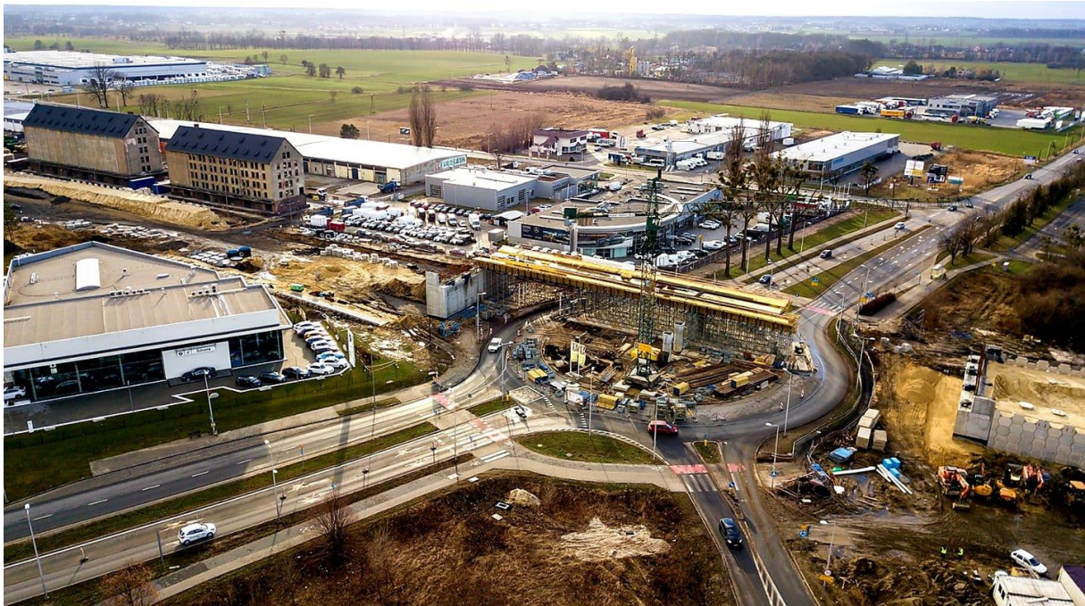
Zdjęcie nr 4 Budowa obwodnicy piastowskiej w Opolu odcinek od obwodnicy północnej do ul. Krapkowskiej Etap II od węzła Niemodlińska do obwodnicy północnej
