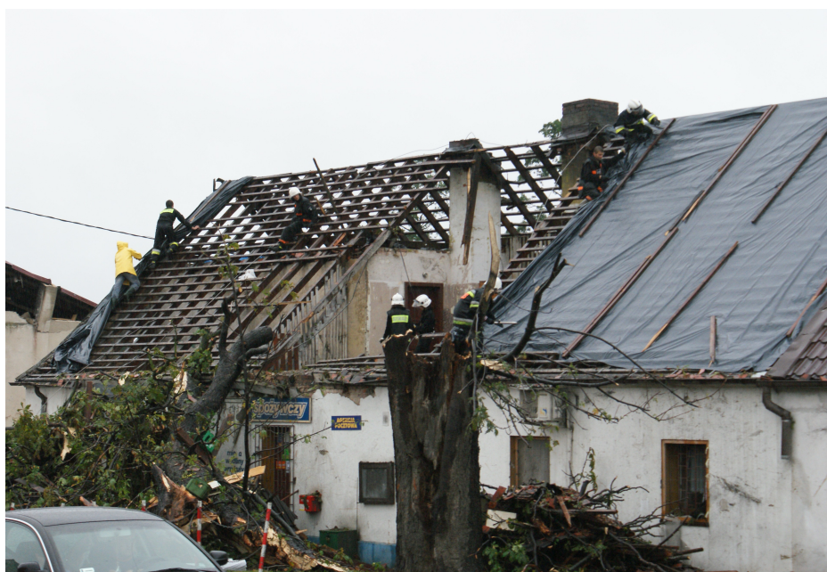
Fot. Przejście trąby powietrznej przez teren powiatu strzeleckiego w 2008 r. Źródło analiza działań KP PSP w Strzelcach Opolskich.
