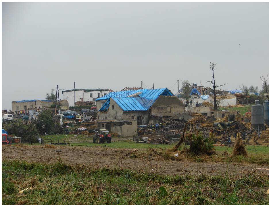
Fot. Przejście trąby powietrznej przez teren powiatu strzeleckiego w 2008 r. Źródło analiza działań KP PSP w Strzelcach Opolskich.
